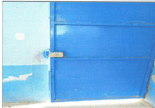
Foto 2: panorama de reparación de puertas
