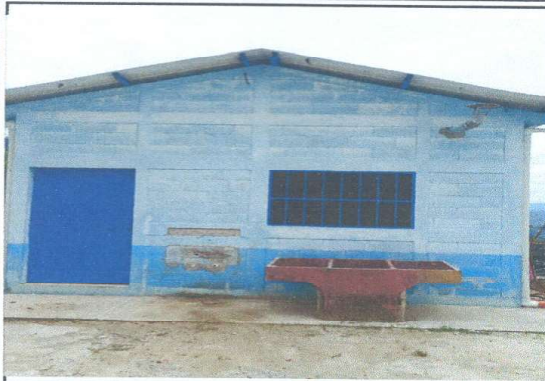
Foto 1: panorama de reparación o sustitución de área de cocina
