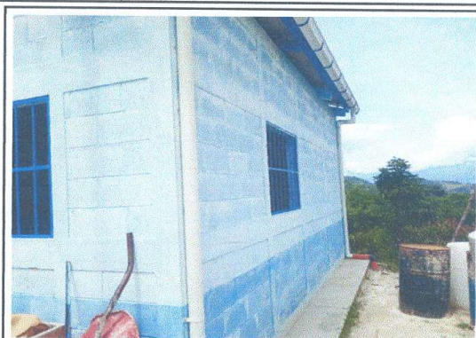
Foto 2: panorama de reparación o sustitución de área de cocina
