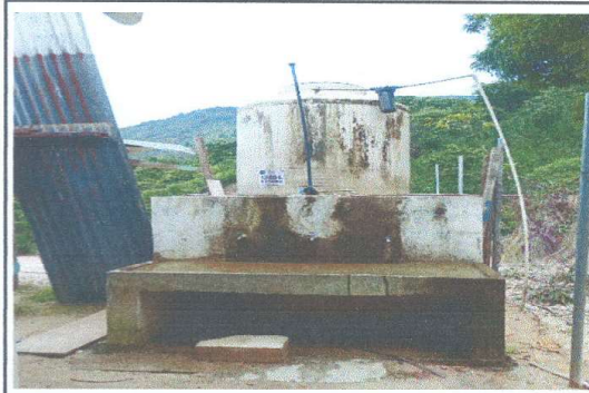
Foto 1: panorama de mejoramiento de red de agua potable
