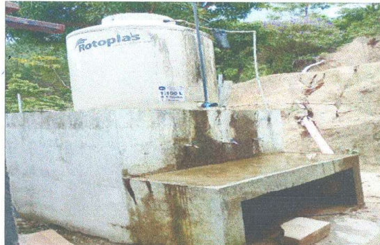
Foto 2 : panorama de mejoramiento de red de agua potable
